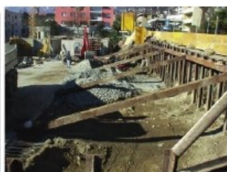
scavi e fondazioni
